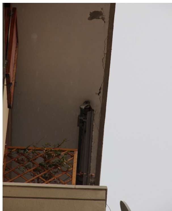
Zone sottocornicione in fase di distacco
