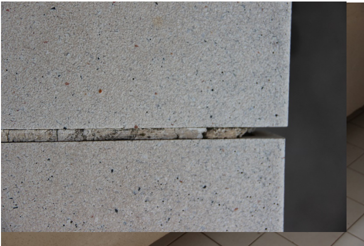
Particolare distacchi presenti nei parapetti balconi
