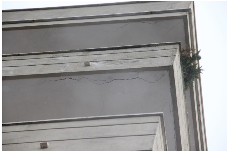
Zone sottobalcone in fase di distacco
