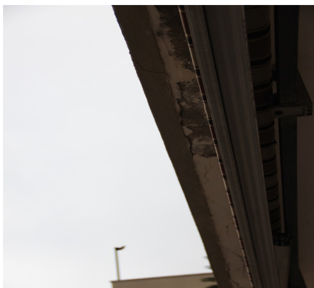
Lesioni al sottocornicione lato interno
