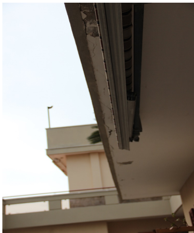
Lesioni al sottocornicione lato interno
