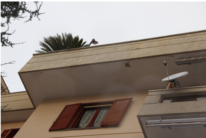
Zone sottocornicione distaccate facciata lato mare
