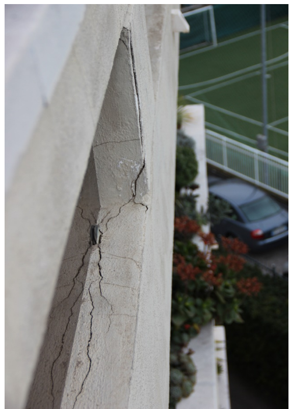
Particolare vuoti presenti nei parapetti in fase di distacco
