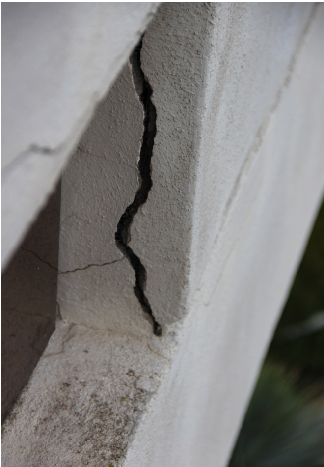
Particolare vuoti presenti nei parapetti balconi (lato esterno)
