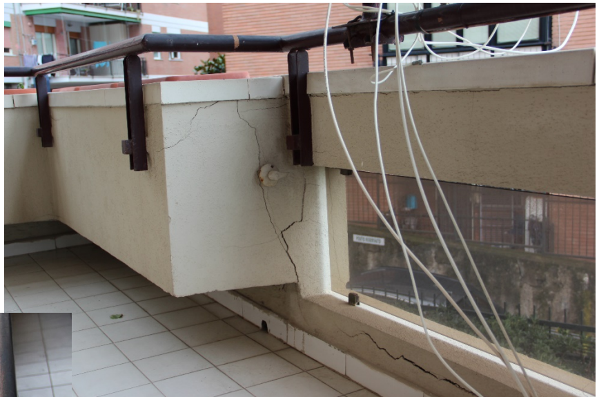
Particolare coprimuri ai parapetti balconi
