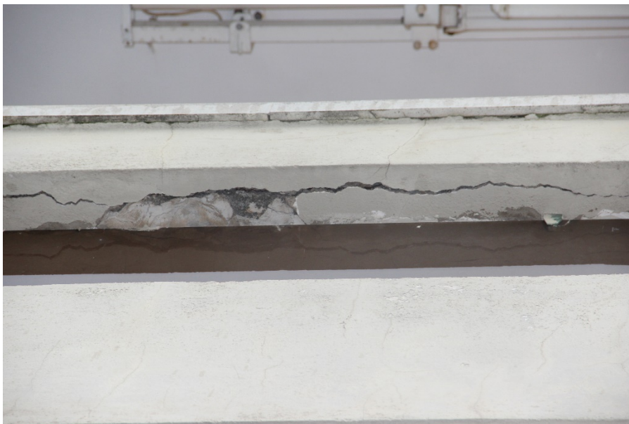
Particolare vuoti presenti nei parapetti balconi
