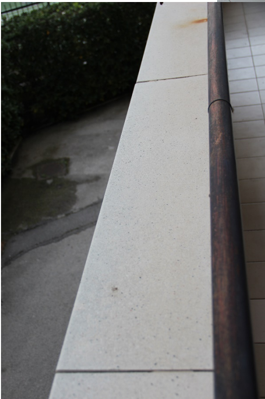
Particolare coprimuri ai parapetti balconi
